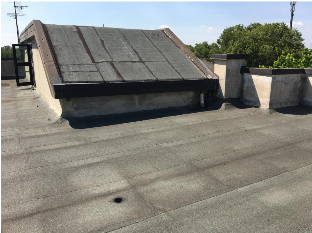
Foto 4: fronte piano copertura di intervento
