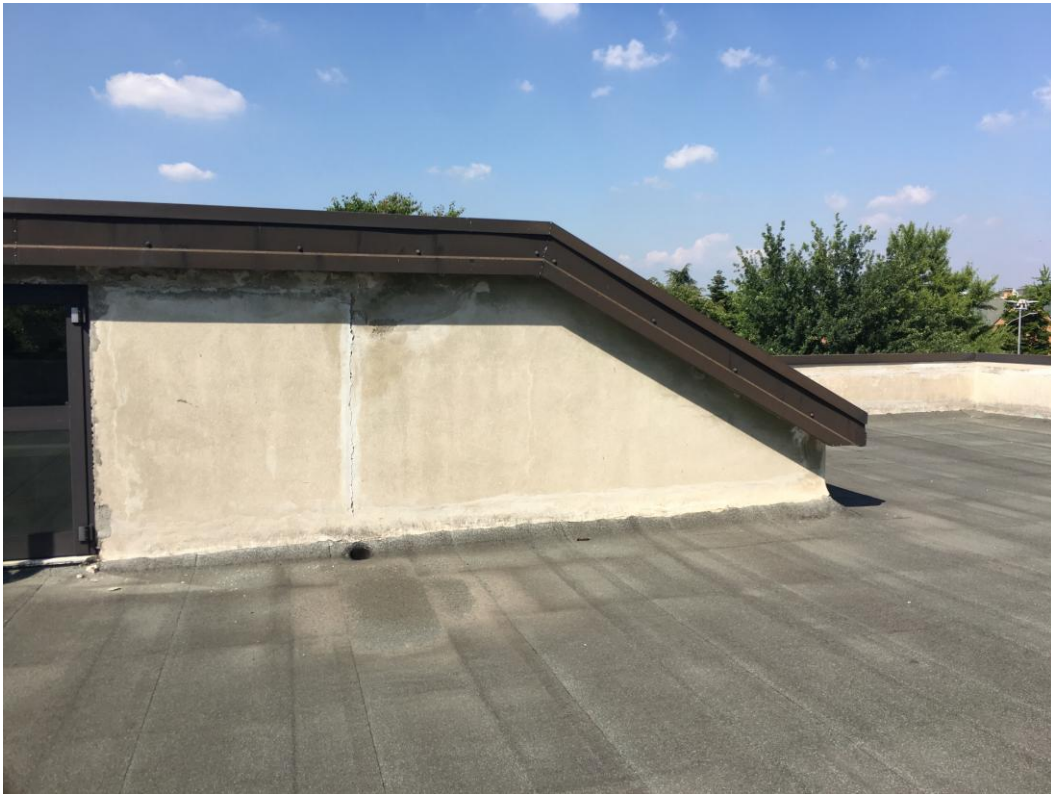
Foto 3: prospetto piano copertura di intervento
