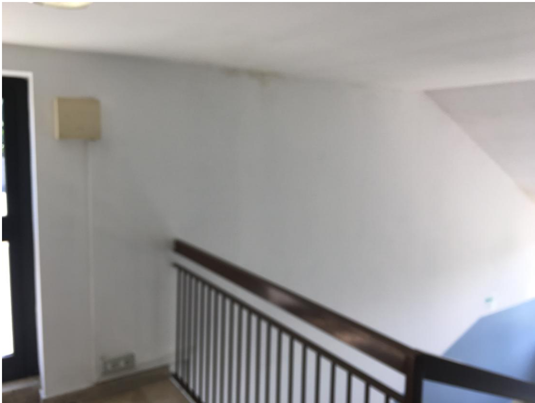
Foto 7: intradosso piano copertura zona scala
