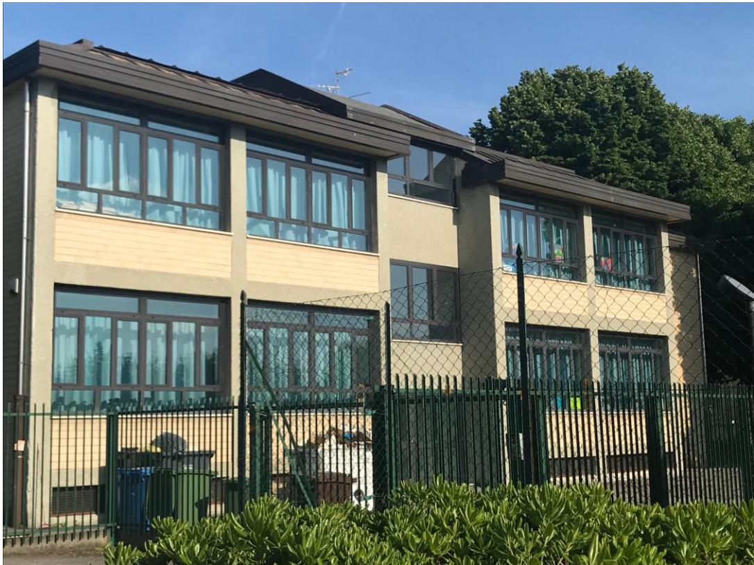
Foto 1: Vista esterna della scuola
