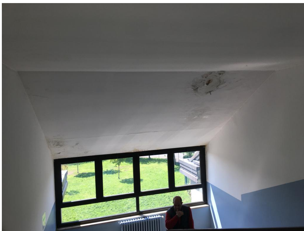
Foto 6: intradosso piano copertura zona scala
