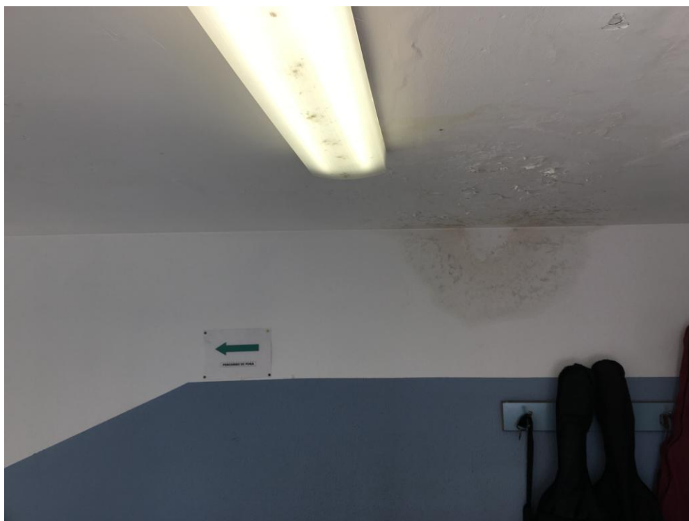
Foto 5: intradosso piano copertura
