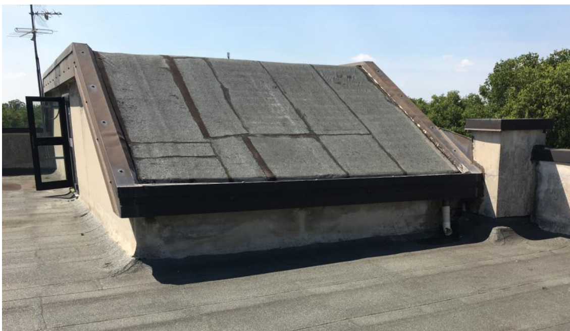
Figura 2 - Vista copertura vano scale
