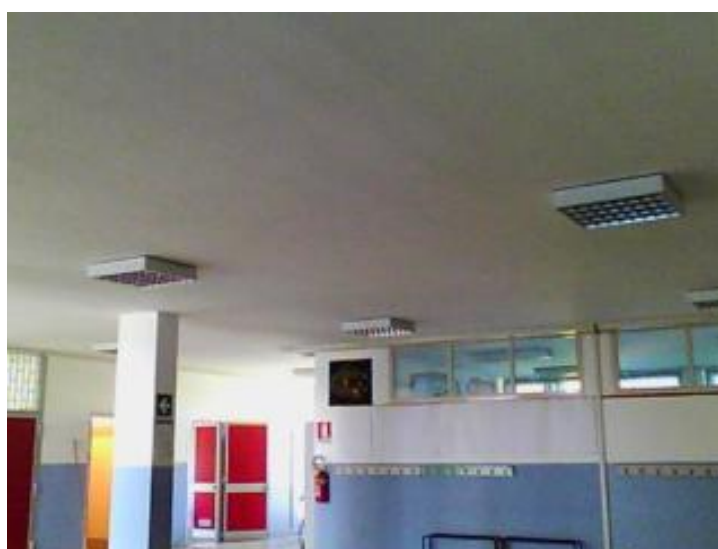
Figura 4 - Vista dell'intradosso del solaio di copertura del piano primo
