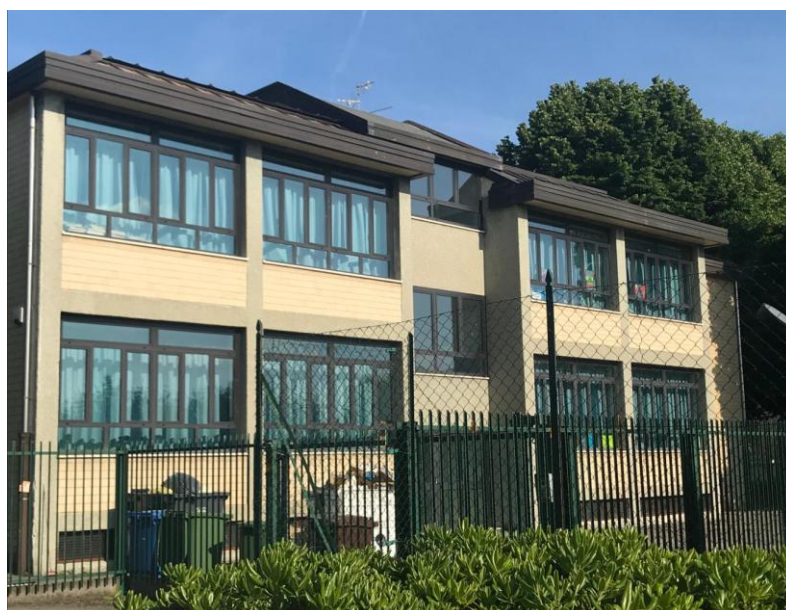
Figura 1 - Vista facciata principale della scuola
