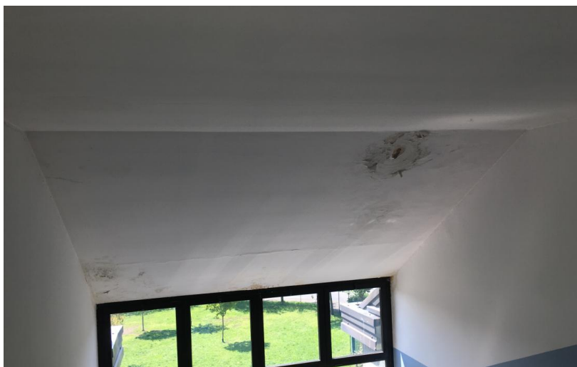
Figura 3 - Vista dell'intradosso del solaio di copertura del corpo scale
